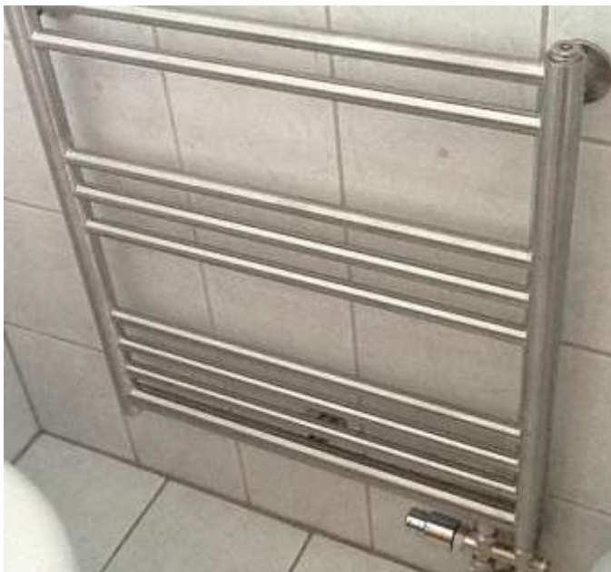
Edelstahlheizkörper Bauart EGIN, sehr kompakt, mit Wunschaufteilung der Rohre und Sonderanschluss an Einrohrsystem.
