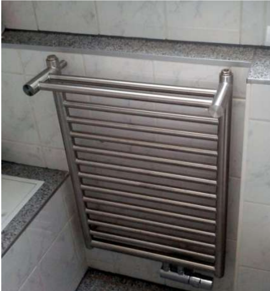
Edelstahlheizkörper mit Handtuchhalter, Bauart EGIN. Hier als sehr kompakte und praktische Sonderanfertigung, mit durchfluteter Handtuchauflage und exzentrischem Sonderanschluss.
